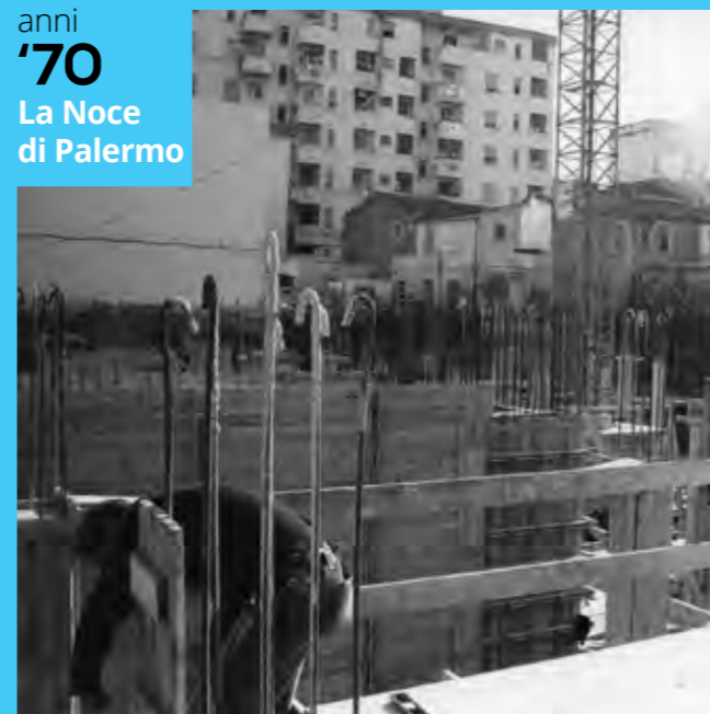
Lavori di costruzione a La Noce di Palermo Archivio Fotografico Valdese
