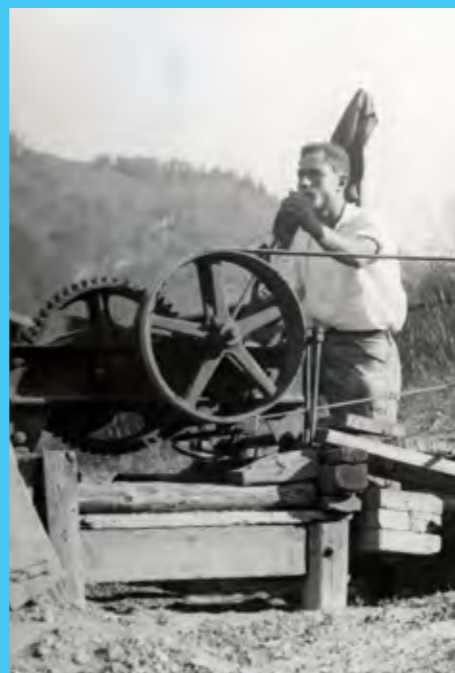
Lavori di costruzione ad Agape Archivio Fotografico Valdese
