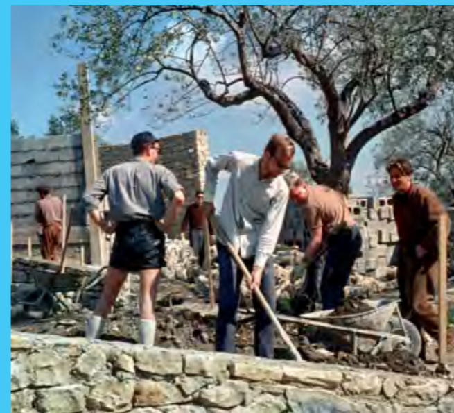
Fasi di costruzione dell'edificio scuola materna - 1963 Archivio Servizio Cristiano, Rieti
